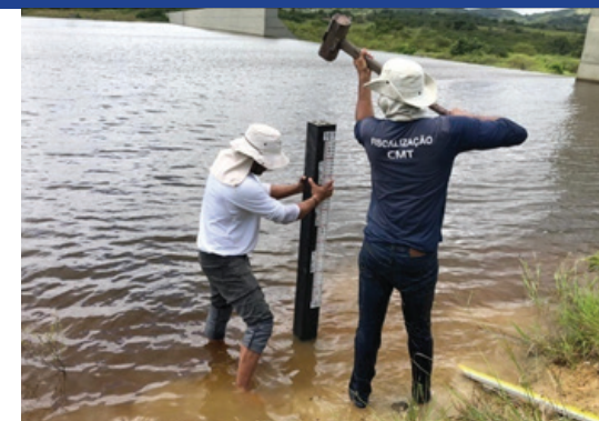
Instalação de réguas limnimétricas na barragem Jacarecica I.
